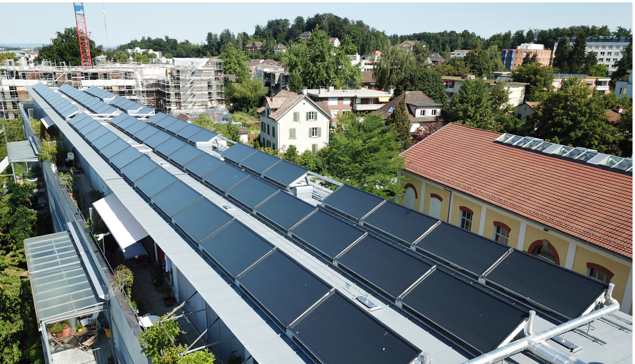
Wohnüberbauung «Im Werk» Uster: Reduktion der CO 2 -Emissionen um 25 t pro Jahr, © Soltop Energie Lotissement résidentiel « Im Werk » à Uster : émissions carbone réduites de 25 t/an, © Soltop Energie
