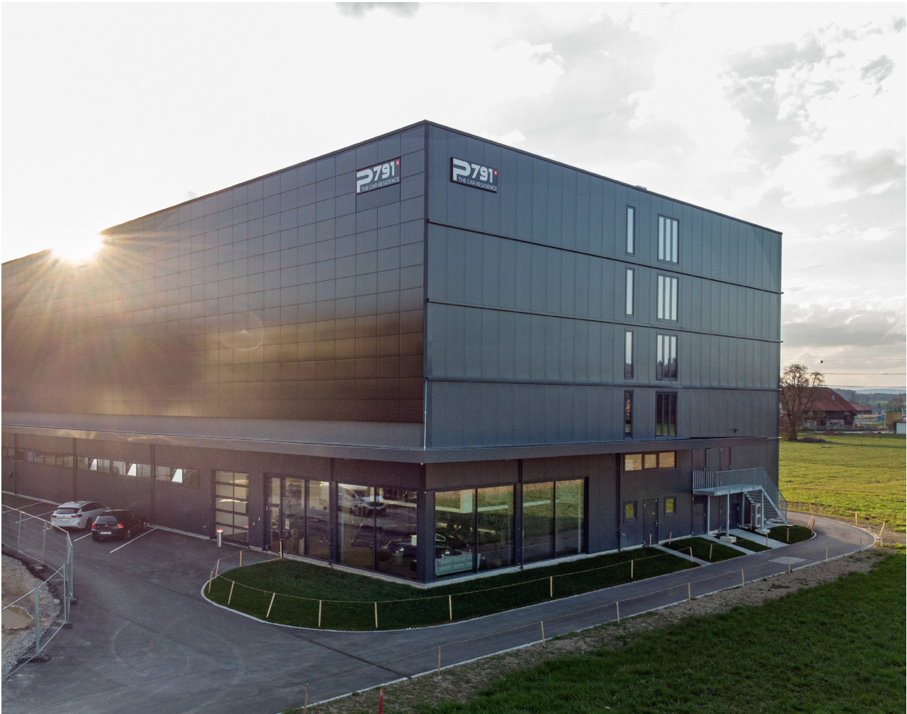
Solarfassade Autohotel Belp, © 3S Swiss Solar Solutions AG Façade solaire, Autohotel (stockage de véhicules), Belp, © 3S Swiss Solar Solutions AG
