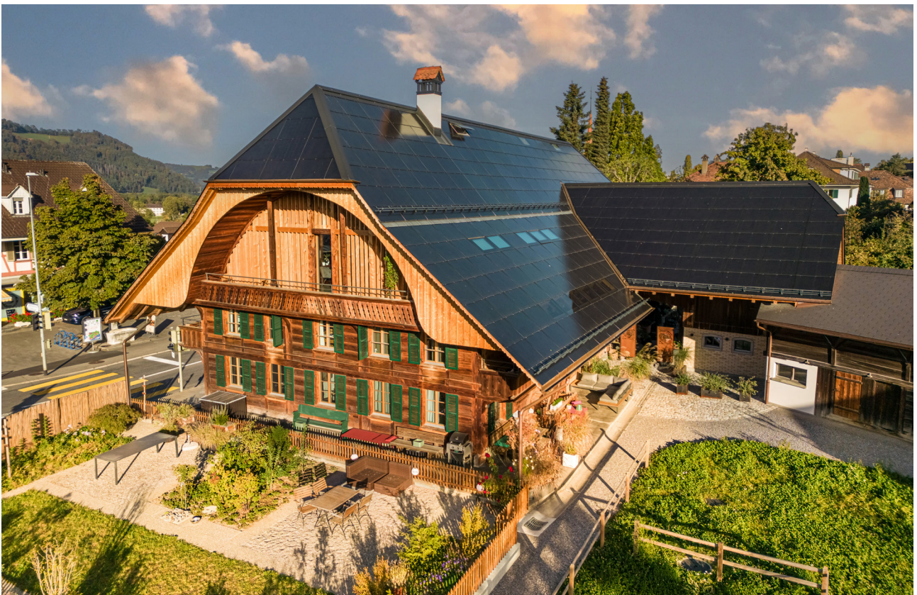
Das denkmalgeschützte MFH von 1813 erstrahlt nach der Sanierung mit der vorbildlich dachintegrierten 103 kWc starken PV-Anlage in neuem Glanz, © Schweizer Solarpreis 2023 La maison plurifamiliale de 1813, classée monument historique, dans sa peau neuve après la rénovation, y compris l'installation PV de 103 kWc, intégrée de manière exemplaire, © Prix Solaire Suisse 2023
